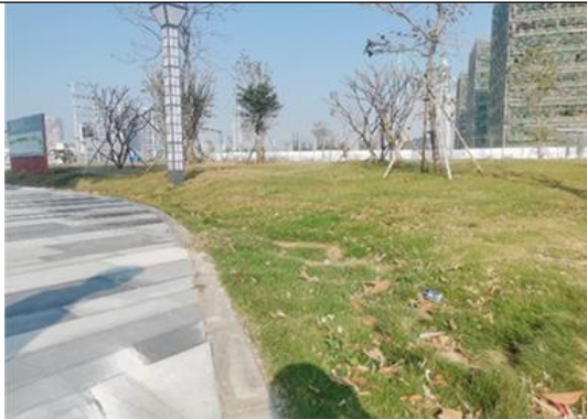
典型问题 1：部分点位高程衔接不合理。路缘石旁的绿地竖向高于硬质路面，径流无法进入海绵设施。
