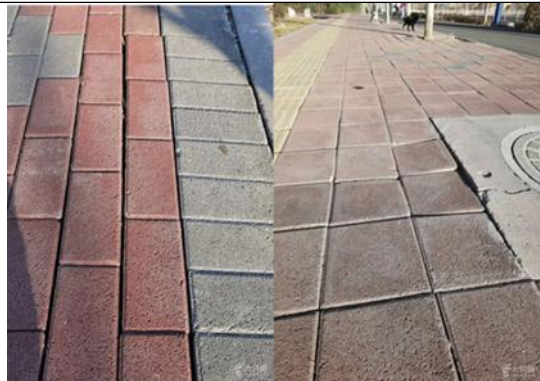
典型问题 2：部分地段透水铺装施工质量不到位，地面平整度不够，地砖基层不牢固。
