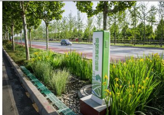
典型问题 2：绿化带做下凹式绿地，但未设置溢流式雨水口。
