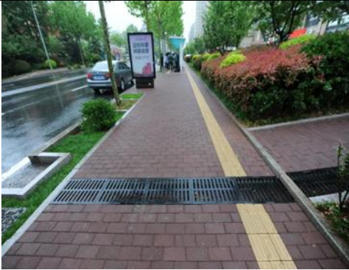
典型问题 1：透水铺装清扫不及时，颗粒物多，渗透性能衰减，透水砖已经出现堵塞。
