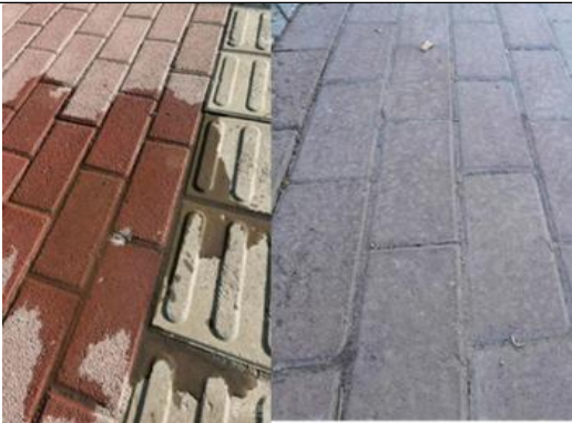
典型问题 1：透水铺装清扫不及时，颗粒物多，渗透性能衰减，透水砖已经出现堵塞。
